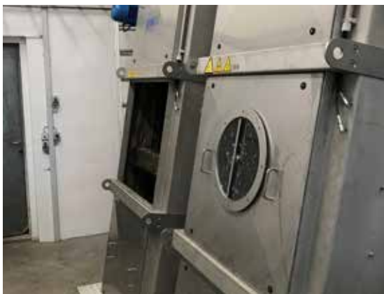
Ristefang, som desværre ikke kan være en del af rundvisningen, er det allerførste spildevand møder på rensenanlægget.
