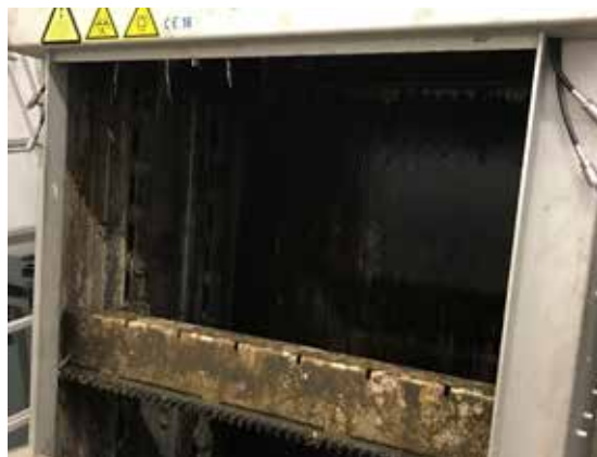
Ristefang, som desværre ikke kan være en del af rundvisningen, er det allerførste spildevand møder på rensenanlægget.
