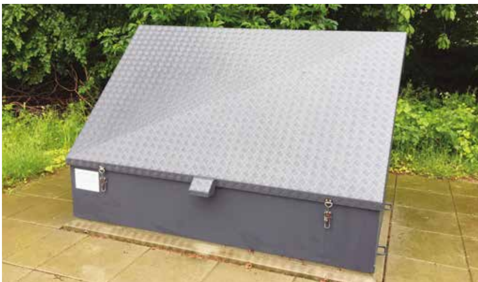
Borehuset ved Snekkersten Idrætsforening. Her går boringen 150,5 meter ned i jorden. Boringen leverer vand til vandværket på Agnetevej lige i nærheden.
