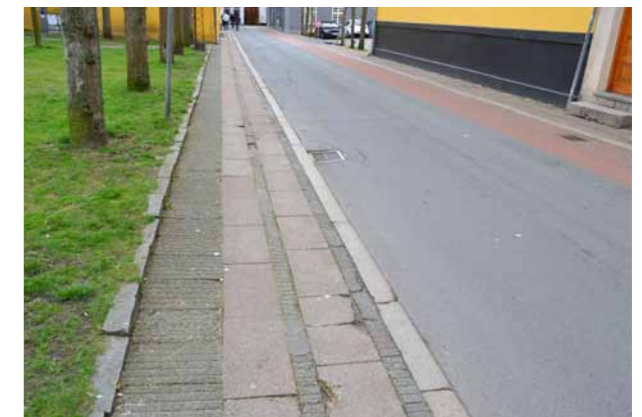
Gågader og fortove med belægninger i kritisk tilstand
